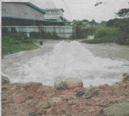
KEADAAN paip yang pecah di Setia Alam hingga menyebabkan penduduk di Klang dan Kuala Langat, Selangor terputus bekalan air semalam.
